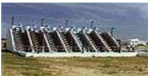
În Memphis, Tennessee 7 șuruburi Arhimede sunt folosite pentru recircularea apei de răcire pentru centrala electrică.
